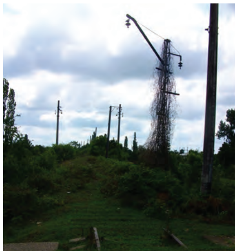
Il. 32. Zniszczenia w Gali II
