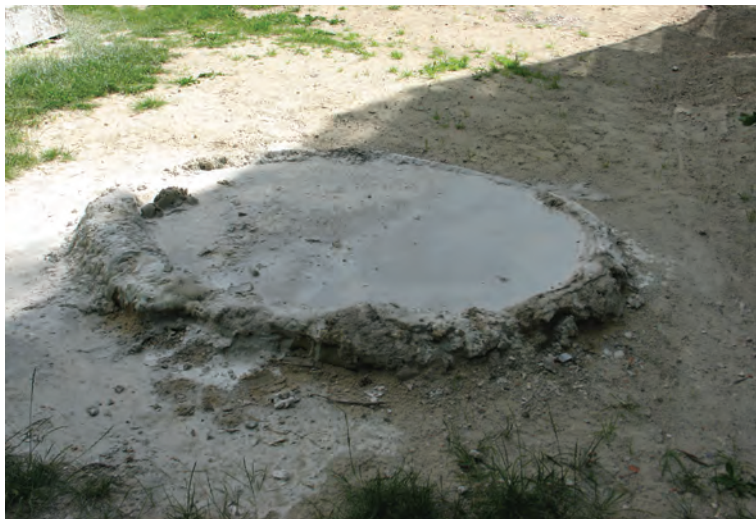
Il. 8. Pełna świeżej zaprawy „misa wapienna” wykonana przez robotników remontujących dzwonnice w Chełmie – lipiec 2005 roku
