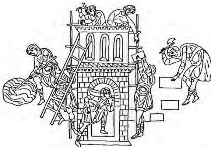
Il. 7. Przygotowywanie zaprawy w okrągłej „misie” na placu budowy kościoła romańskiego – scena z mozaiki z katedry w Monreale, około 1185 roku
